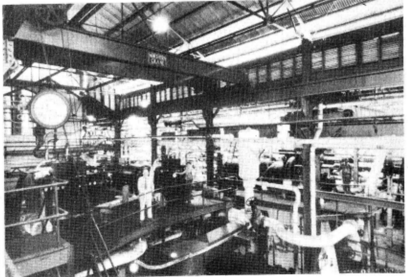
TURBOGENERADORES DE FUERZA ELECTRICA.—Tres turbogeneradores "WESTINGHOUSE". Dos turbos de 2,250 Kw. cada uno y uno de 1,250 Kw.
