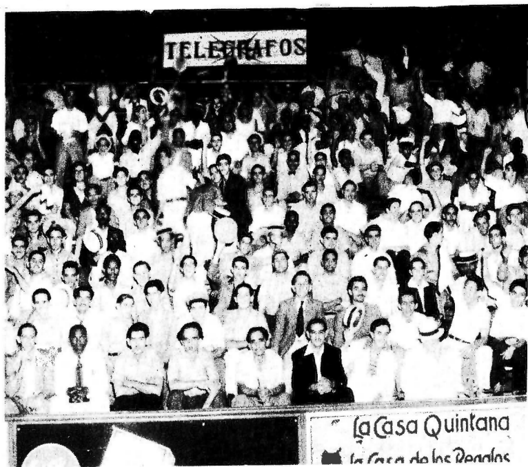
Una vista de las gradas de la Arena Cerveza Cristal, con el techo que le construyó Mariné.
