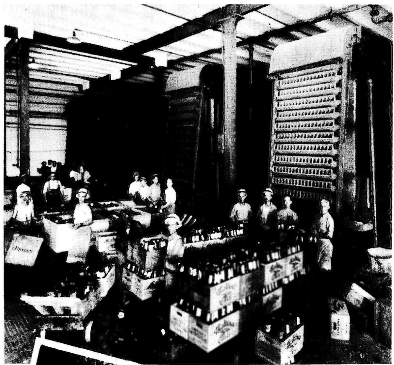
PARTE DEL SALON DE EMBOTELLAR.—Sumergidores para lavar botellas y entrada de operación de 5 colonias para embotellar 100,000 botellas en 8 horas por cada colonia, dando una capacidad este embotellado de 500,000 botellas en 8 horas de trabajo.
